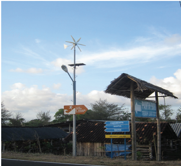
Gambar 2.8 Pemanfaatan energi hibrid untuk penerangan jalan
